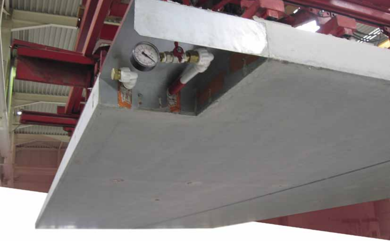
De gladde bekistingszijde vormt een optimale ondergrond voor spuitbepleistering Le côté coffrage lisse forme un support parfait
