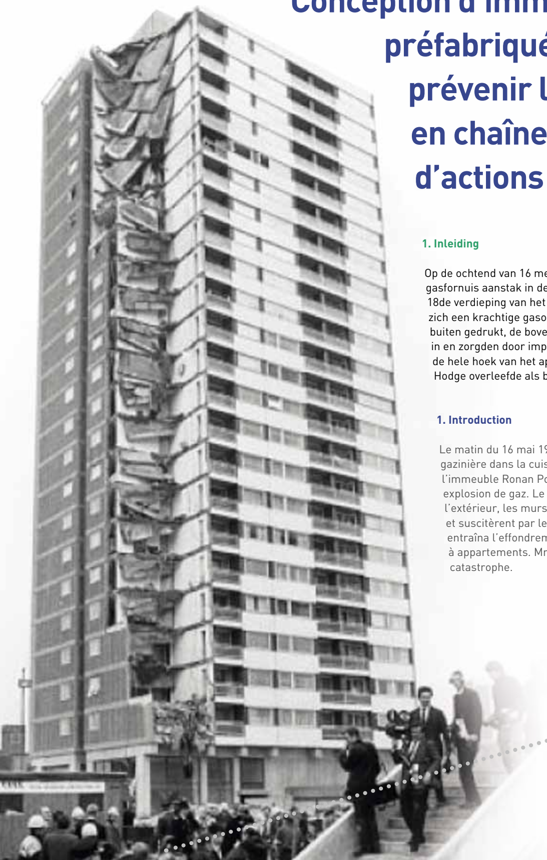
Fig. 1: Voortschrijdende instorting van een hoek van het Ronan Point gebouw in Londen
