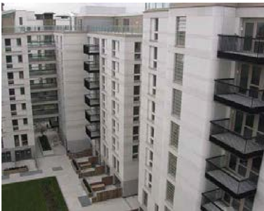
De balkonelementen werden afgewerkt met een zogenaamd vermiculated-effect, een soort kronkelingen die aan kriewelende wormen doet denken. Op het glas van de balkons werden kunstwerken geprint. Les éléments de balcons ont été pourvus d'un effet dit «vermiculé»: des sortes d'ondulations évoquant un enchevêtrement de vers. Des œuvres d'art ont été imprimées sur le verre des balustrades.
