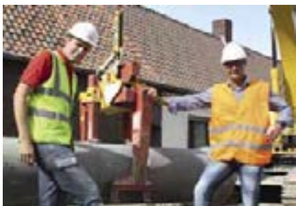
Andy Degrauwe, werfleider voor Stadsbader / chef de chantier pour Stadsbader & Stijn Degraer, commercieel verantwoordelijke bij/ responsable commercial chez Alkern VOR Beton
