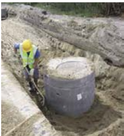
Voor Collector Wortegem worden poreuze betonbuizen met niet poreuze mof en ingebouwde ring gebruikt
