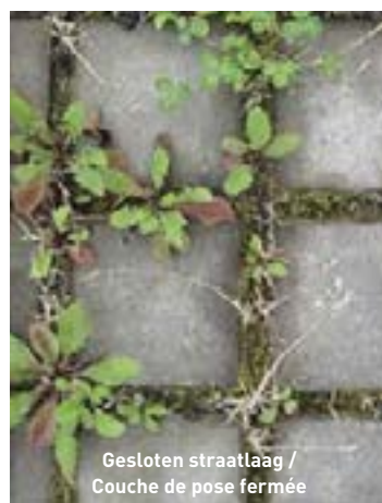
Figure 5 – Impact du type de couche de pose sur la quantité de mauvaises herbes. (Calcaire pollué 0/6,3 comme matériau de jointoiment dans un joint 11mm).
