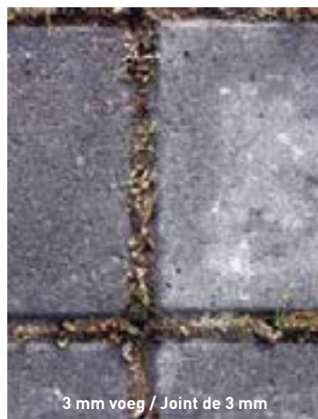
Figuur 4 – Invloed van voegbreedte op onkruidbedekking (zuiver zeezand, 3 mm vs. 11 mm voeg).
