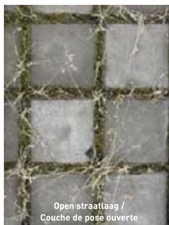
Figuur 5 – Invloed van type straatlaag op veronkruiding. (Voegvulling van vervuilde kalksteen 0/6,3 in 11mm voeg).
