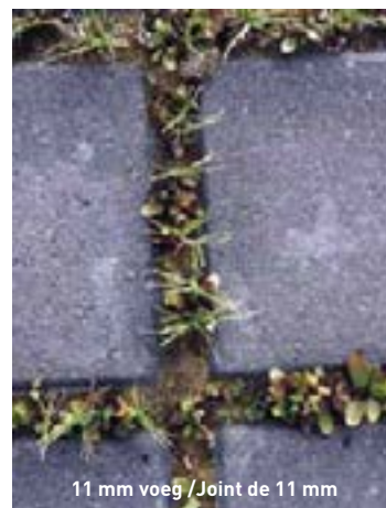
Figure 4 – Impact de la largeur des joints sur la quantité de mauvaises herbes (sable de mer propre, joint de 3mm et de 11 mm)
