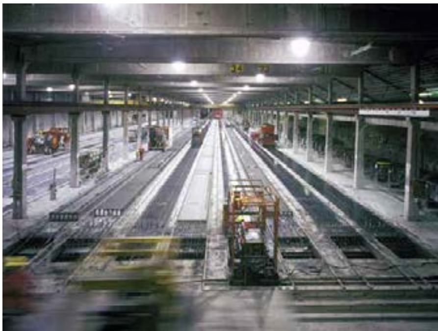
Fig. 1: Moderne prefab hal met rationele productie op lange voorspanbanen Fig. 1: Usine moderne de préfabrication avec fabrication de produits sur de longs bancs de précontrainte
