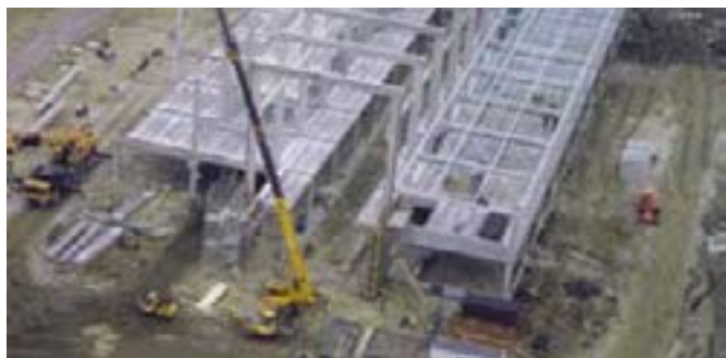
Fig. 9: Montage van de structuur van een kantoorgebouw in prefabbeton
