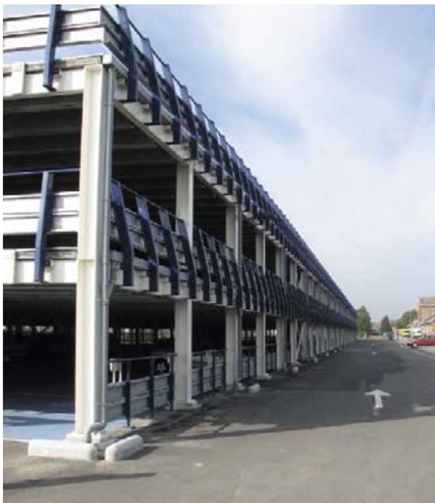
Fig. 3: Voorbeeld van een tijdelijke demonteerbare parking in Gent met stalen balken en kolommen en voorgespannen ribbenvloeren
