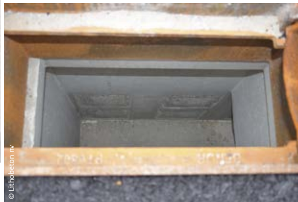
Binnenzijde drainerende straatkolk na plaatsing Partie intérieure drainante de l'avaloir de voirie après la pose
