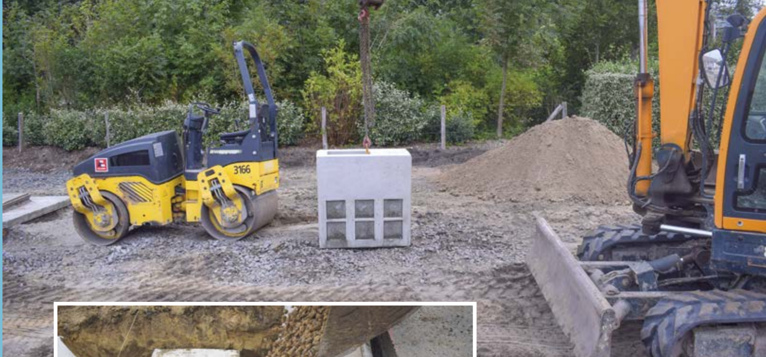
Binnenzijde drainerende straatkolk na plaatsing Partie intérieure drainante de l'avaloir de voirie après la pose
