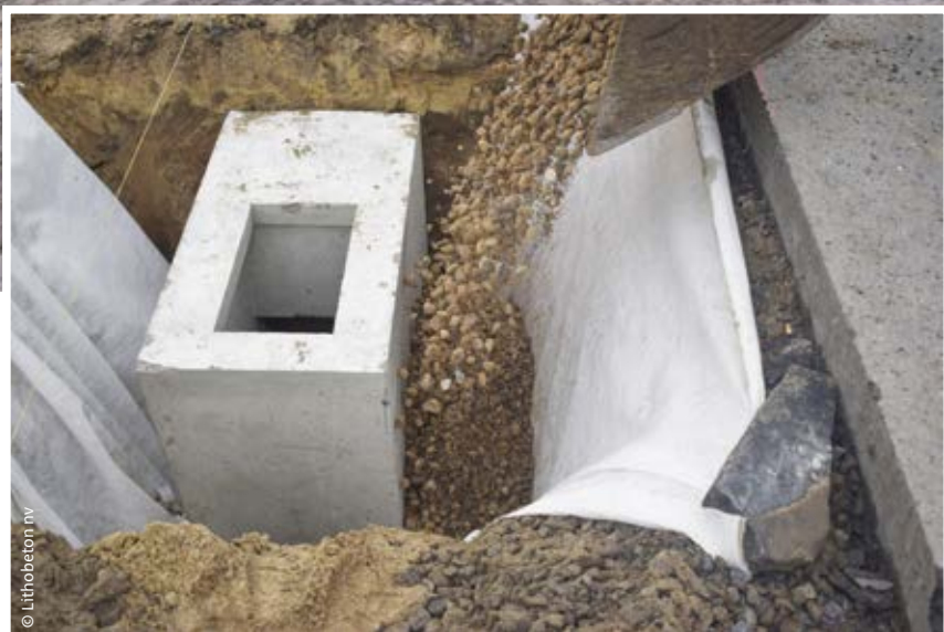
Binnenzijde drainerende straatkolk na plaatsing Partie intérieure drainante de l'avaloir de voirie après la pose
