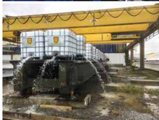
De productie van de brug – De brug na de belastingsproef. La production de la passerelle – La passerelle après l'essai de portance.
