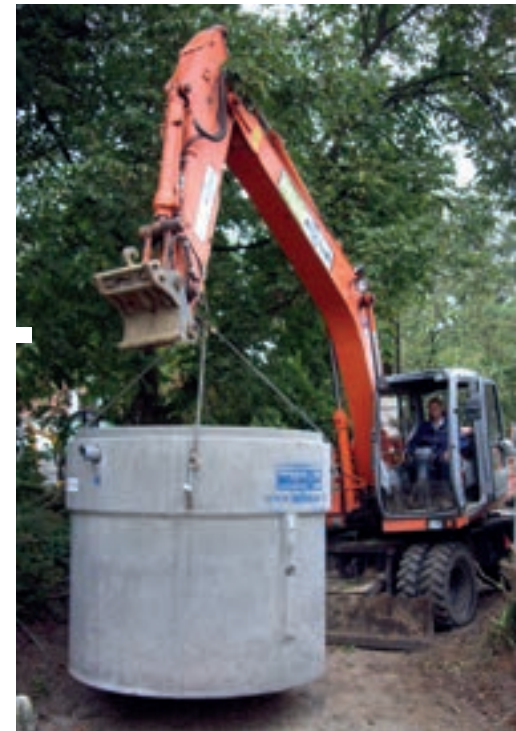
Plaatsing van een voorbehandelingsinstallatie. Placement d'une installation de prétraitement
