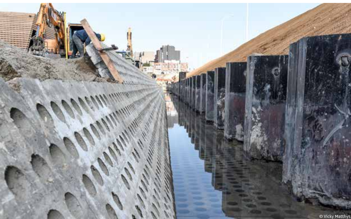
Waterbuffer aan de rand van de site. De buffer houdt de bodemwaterstand op peil. Le bassin de rétention au bord du site. Il maintient à niveau la résistance du sol du site.
