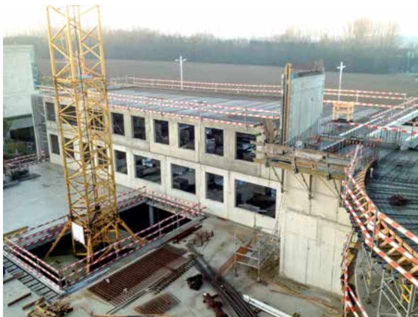
Genesis Braine l'Alleud voor AXA, prefab gevelkaders en welfsels (Echo) Genesis Braine l'Alleud pour Axa, cadres de façade en prefa et hourdis (Echo)
