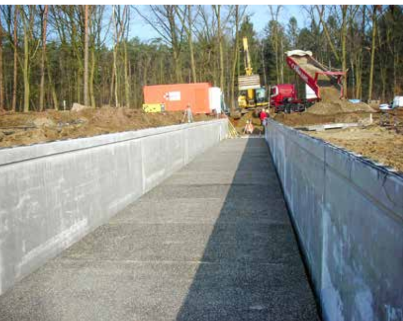
Om het fietspad vlot te kunnen aanleggen, werden naburige vijvers tijdelijk afgevisd en drooggelegd.
