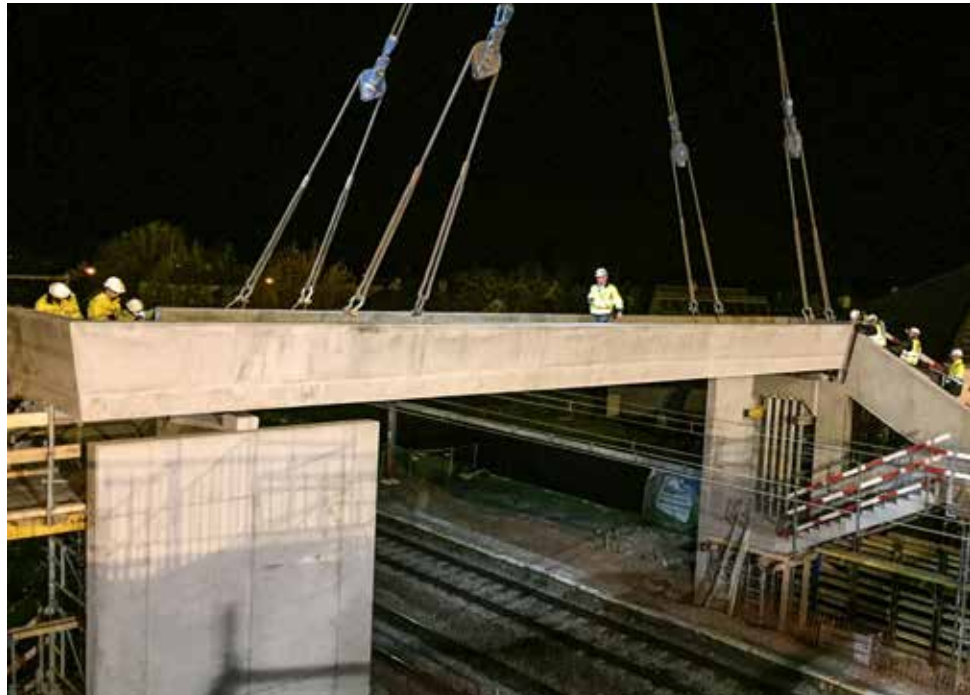
Pose de la passerelle piétonne
